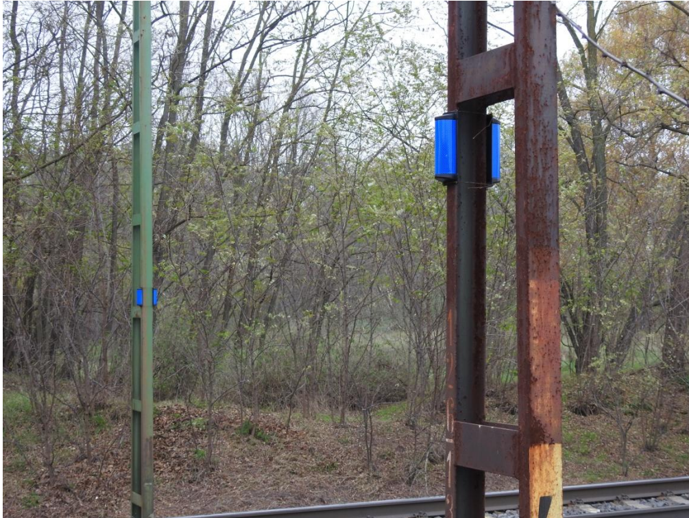
25. ábra Kékfóliás optikai vadriasztó prizma az 1 számú, Budapest–Hegyeshalom–Rajka vasútvonalon, Nagyszentjános és Győrszentiván között, Cuha-Bakonyér keresztezési pontjánál.
